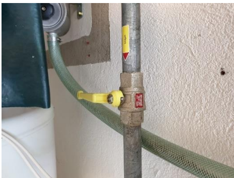
Abbildung 47 Senkrechter Kugelhahn
