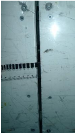
Abbildung 60 Spaltmass &gt; 5mm
