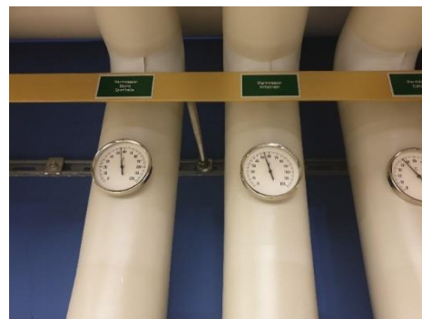
Abbildung 38 Thermometer Warmwasserverteiler
