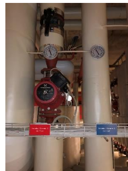
Abbildung 9 Umwälzpumpe älterer Stand
