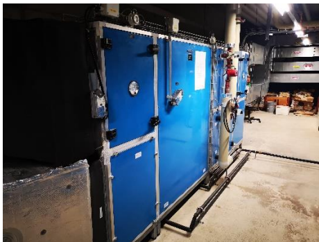
Abbildung 19 LA Gard. HB / Sauna / Eingang
