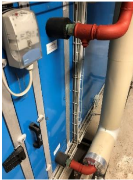
Abbildung 12 Anschlussstutzen Luftherhitzer
