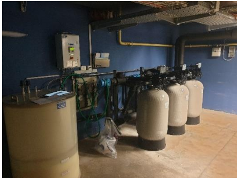
Abbildung 39 Tripplle Enthärtungsanlage
