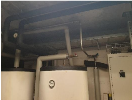
Abbildung 43 Sicherheitsventil WW-Eisreinigung
