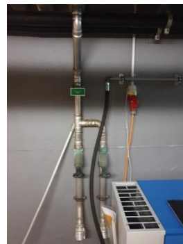
Abbildung 45 Füllstützen für Hallenbad
