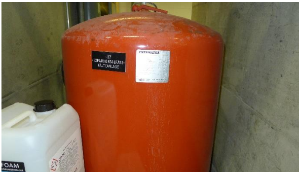
Abbildung 59 Expansion Kälteträgernetz
