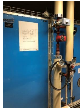
Abbildung 13 Anschlussgruppe Luftherhitzer
