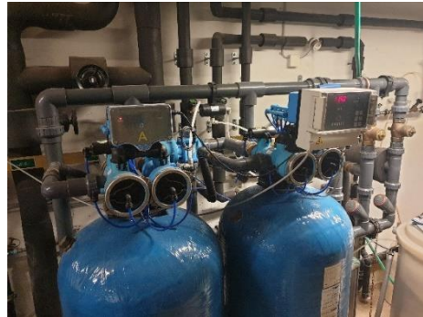
Abbildung 40 Doppel Enthärtungsanlage
