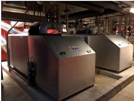
Abbildung 3 Gaskessel 1 + 2
