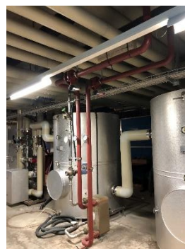
Abbildung 15 Anschluss Wärmetausche Warmwasser
