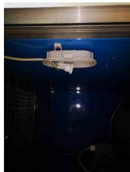
Abbildung 20 LA Gard. HB / Sauna / Eingang
