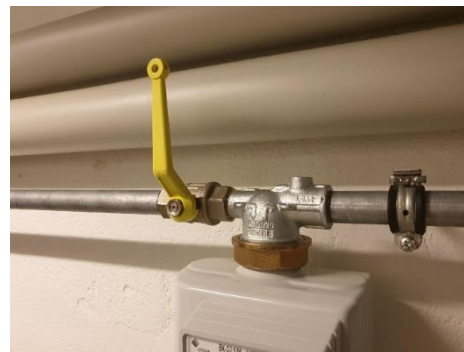
Abbildung 48 Waagrechter Kugelhahn
