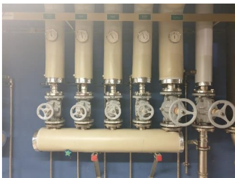
Abbildung 37 Warmwasserverteiler
