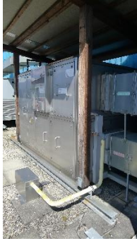
Abbildung 36 Entfeuchtungsanlage EH
