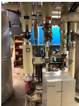
Abbildung 8 Heizgruppe Warmwasser
