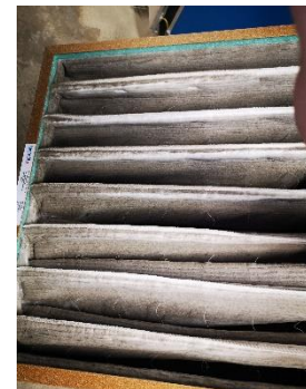
Abbildung 21 LA Gard. HB / Sauna / Eingang
