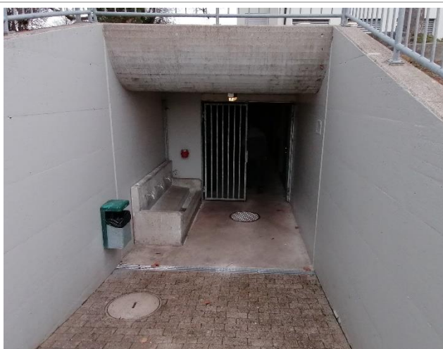
Zugang Garderoben in Zivilschutzanlage
