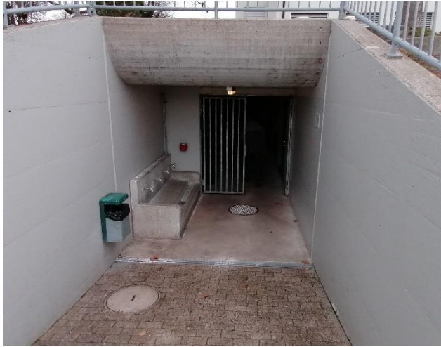
Zugang Garderoben in Zivilschutzanlage
