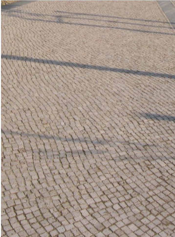
Referenzbild ungerichtete Pflasterung
