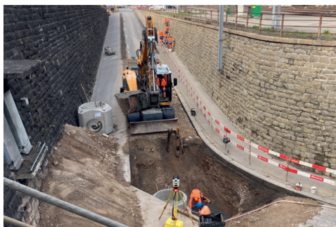
Imposante Kanalisationsarbeiten an der Güterstrasse.
