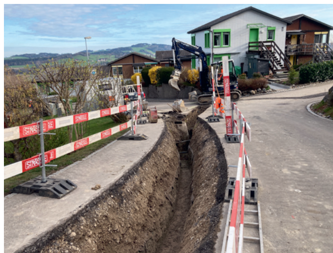
Leitungsersatz der Wasserversorgung in der Obermoosbergstrasse.
