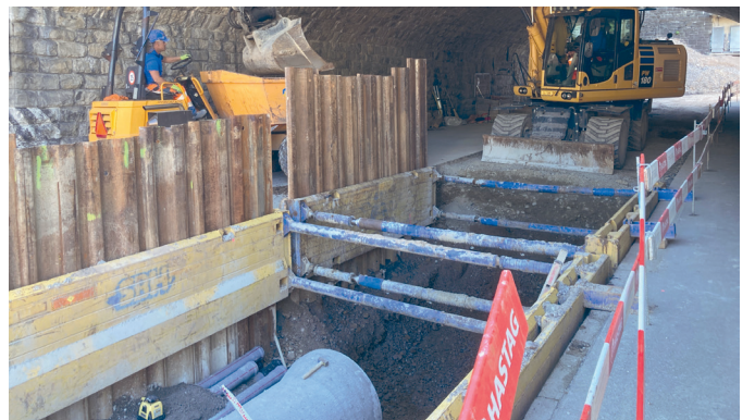
Enge Platzverhältnisse in der SOB-Unterführung von der Güterstrasse zur St. Gallerstrasse.
