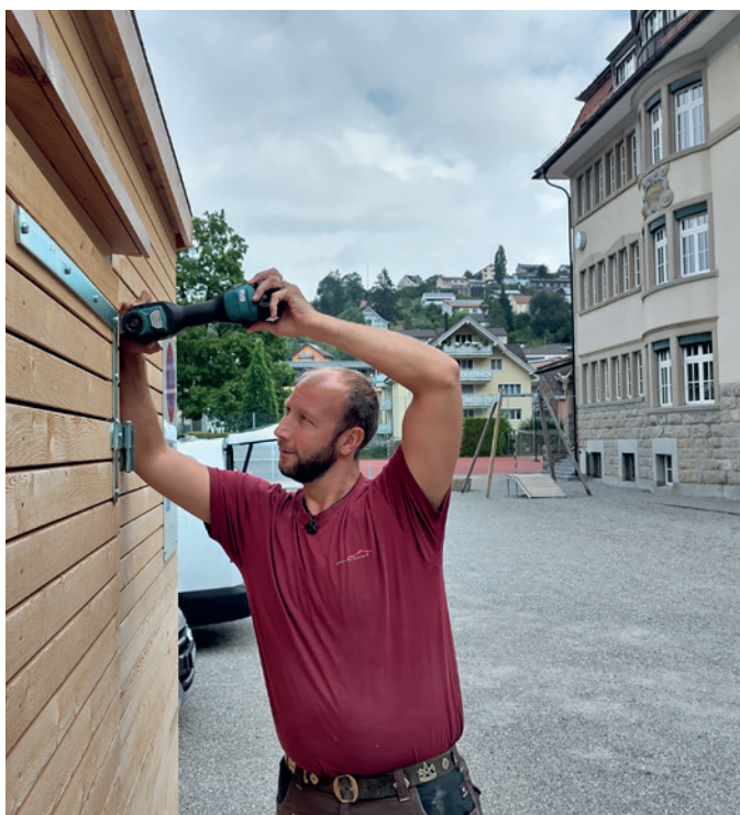
Der Unterhaltsbetrieb (im Bild Werner Knöpfel) entwarf und fertigte mehrere Abfallcontainer-Häuschen wie jenes beim Schulhaus Wilen.
