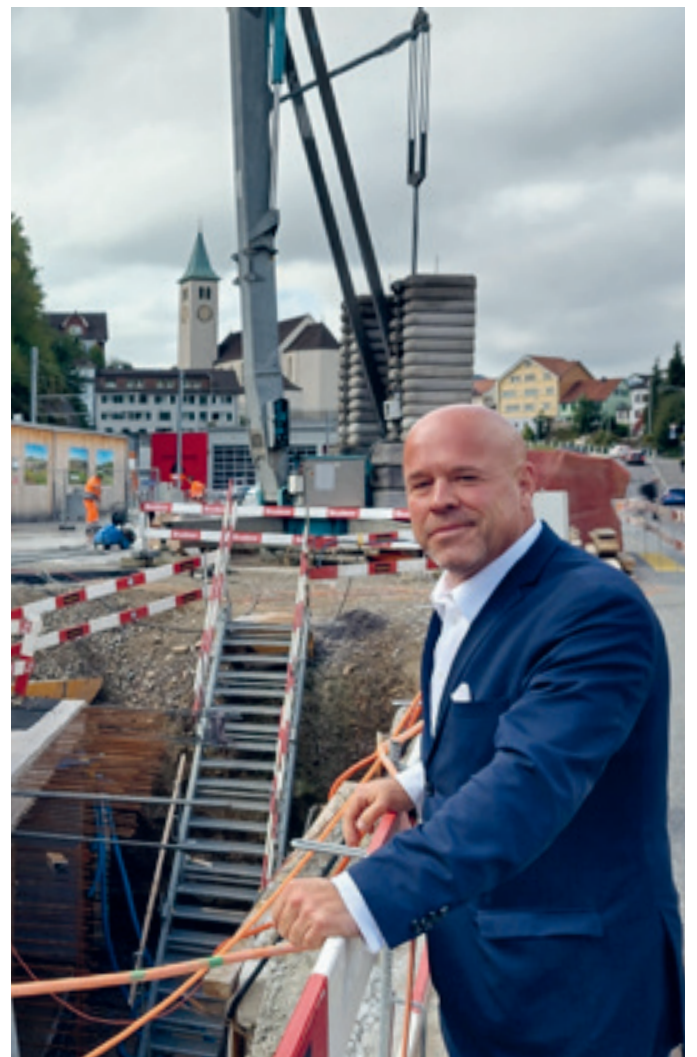
Normann Feyl besichtigt die Arbeiten an der neuen östlichen Unterführung.
