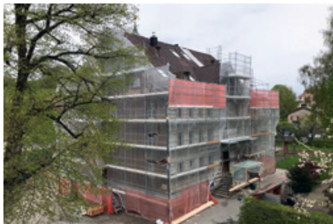
Das Schulverwaltungsgebäude Waisenhaus erhält auf drei Seiten eine neue Fassade.
