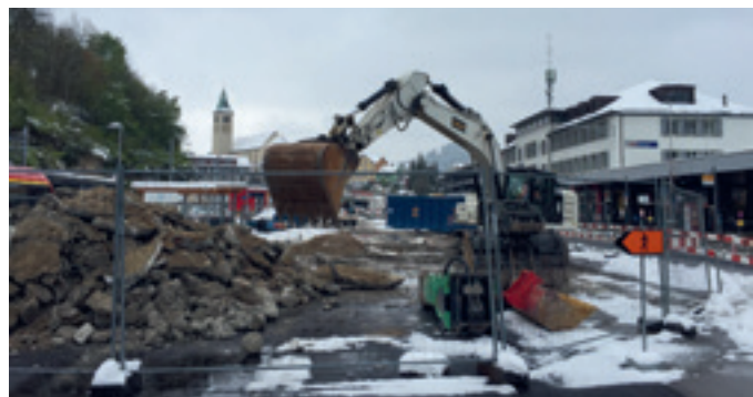
Die Bahnhof-Baustelle am 23. April: Der Mercato-Shop und das alte Perrondach sind abgebrochen.
