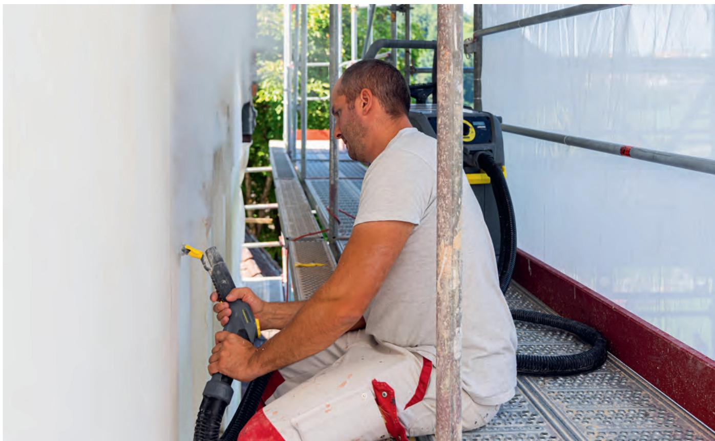
**Die Farbe wird mit einem Dampfreiniger abgetragen.**
