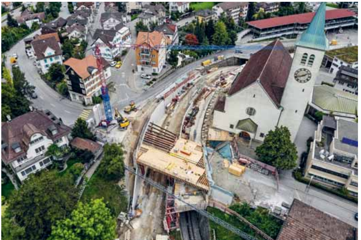
Die Schalung für die neue Brücke wird montiert. (Bild: Hanspeter Schiess Fotografie, 5. September 2022)
