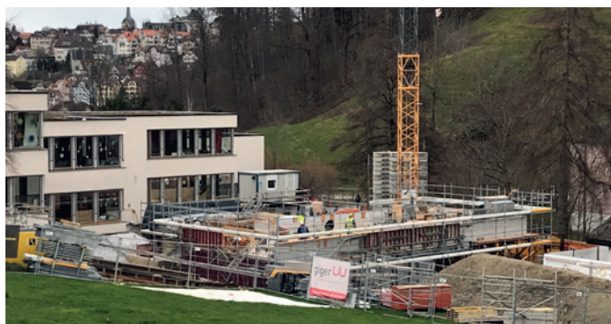
Die Bauarbeiten beim Kindergarten Müli laufen auf Hochtouren.
